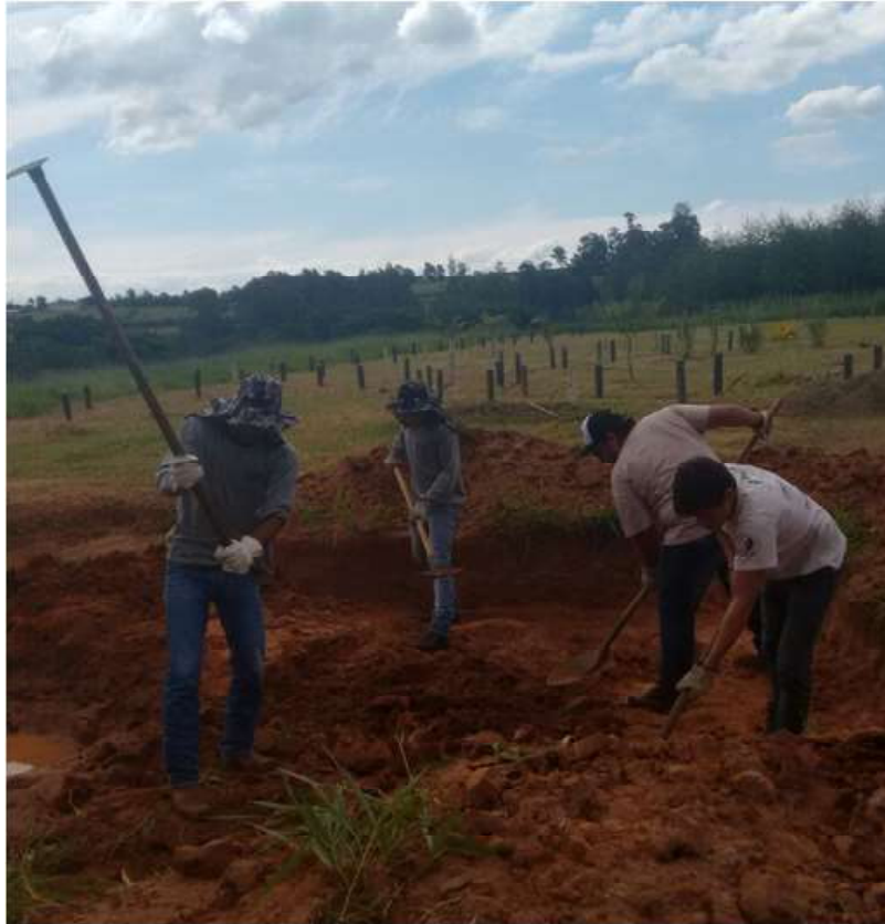
Figura 4. Escavação de lago na Alameda Amazônia
