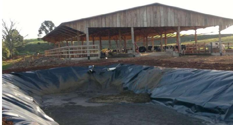
Figura 1: modelo de construção da esterqueira
